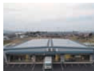
田原本支所 273 kW 2014年10月設置
