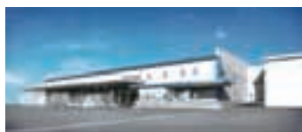
物流センター：新要冷棟 (田原本町)
