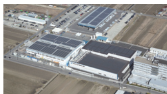
田原本物流センター東棟 低温センター、 西棟 常温センター、 北棟 田原本支所 (田原本町)
