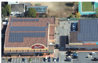
【(株)コープエナジーなら】による太陽光発電システムの設置（コープ朱雀）
