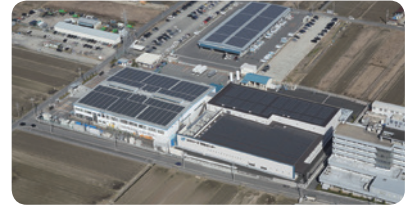
田原本発電所
