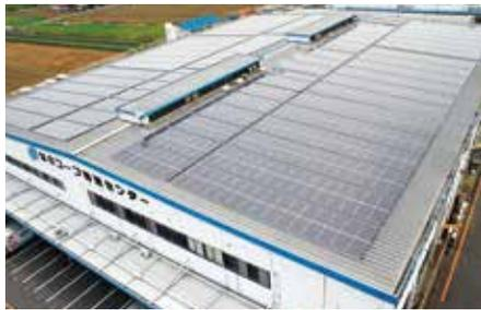
田原本発電所2号機 設備容量 273Kw
