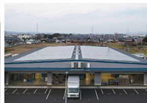
●田原支所の太陽光発電システム(273kW)
