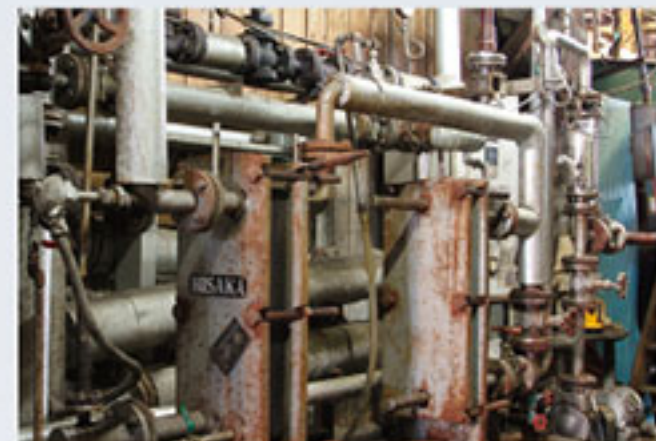
③精製 調合し瞬間高温加熱して、殺菌（色・香り・味を整える）を同時に行います。加熱殺菌後、醤油をろ過機を通して清澄度を高めます。
