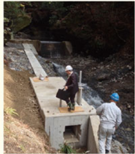
▲東吉野「つくばね発電所」の施工現場
