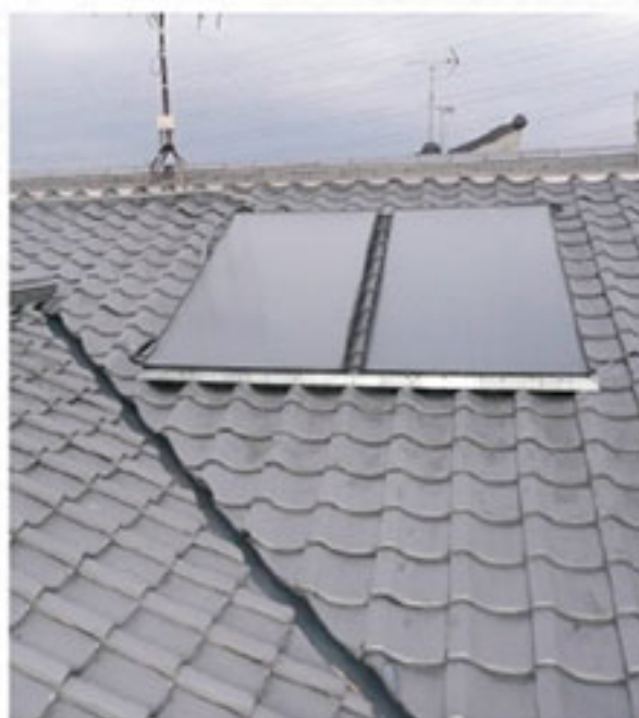
ご家庭への太陽熱温水器設置
