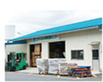
リサイクル中間処理センター(田原本物流センター)
