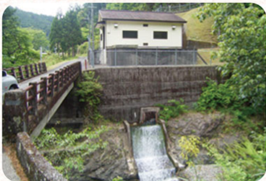
ならコープグループが増強をおこなう村営の小又川発電所(98kW)
