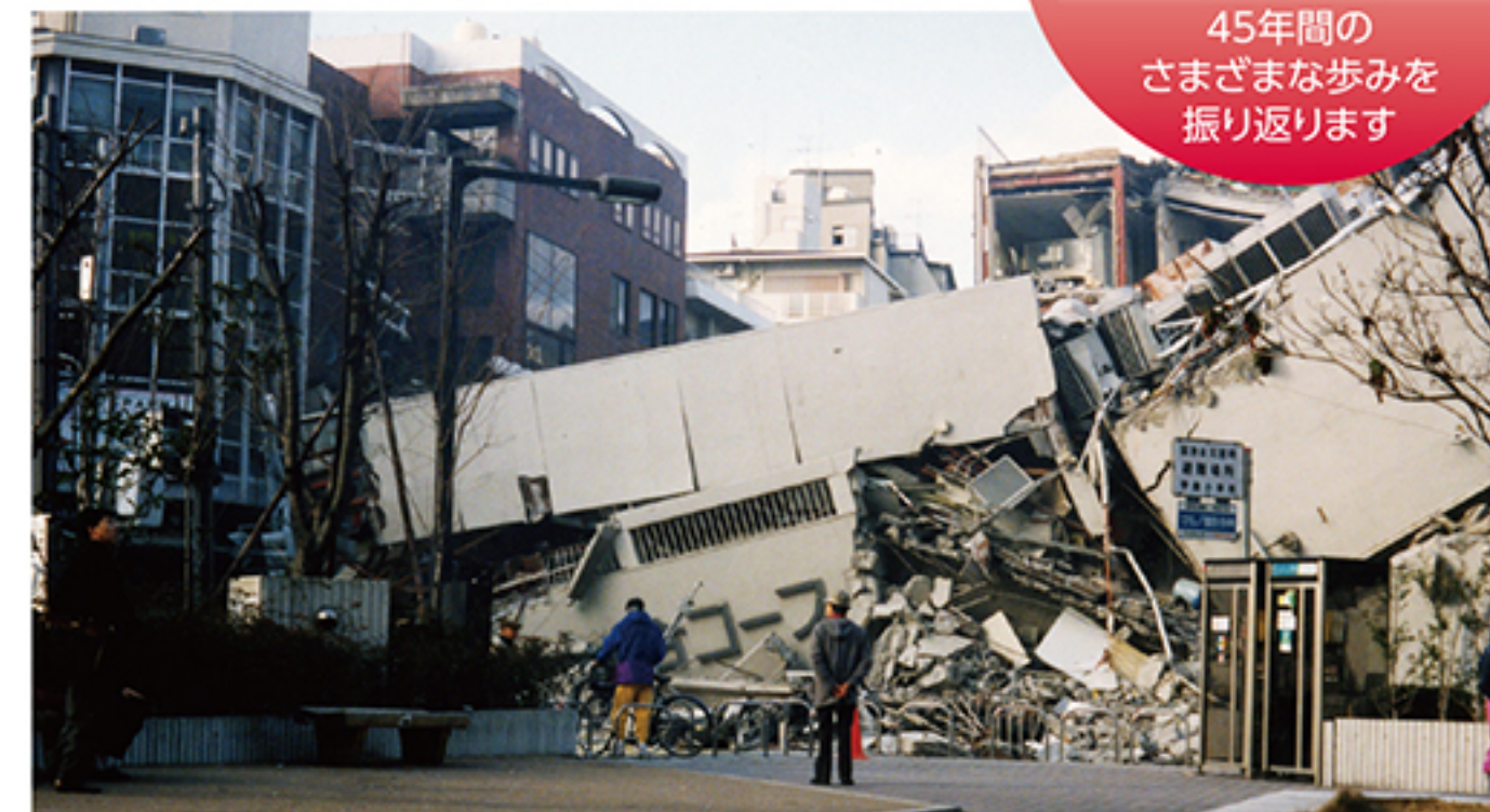
全壊したコープこうべ本部の建物
