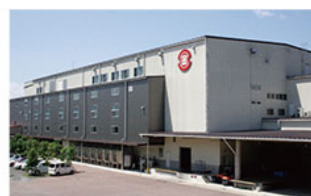
ドレッシング工場
