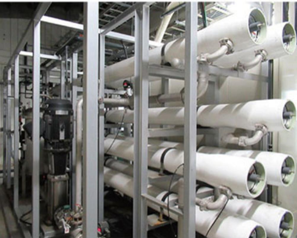
RO膜(逆浸透膜)装置。工場内の水は全てきれいにろ過される
