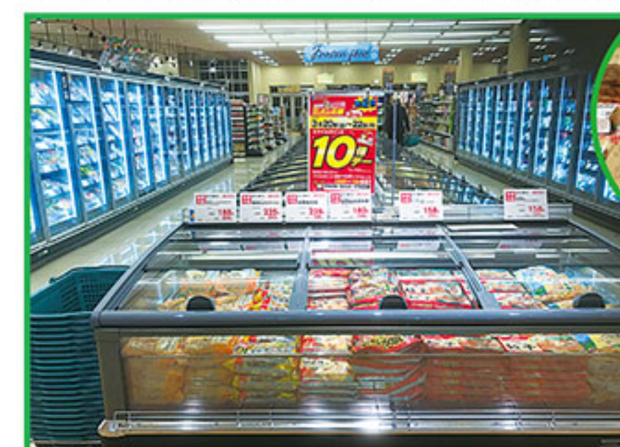
冷気拡散防止する扉やスライドカバー付の冷凍ケース
