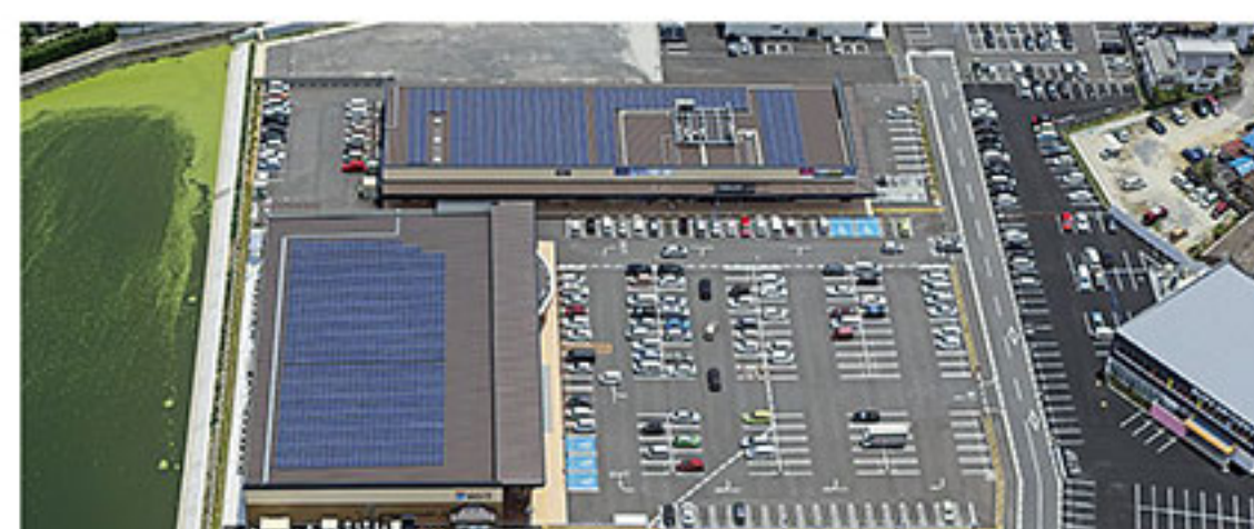
コープなんごうの屋上太陽光パネル
