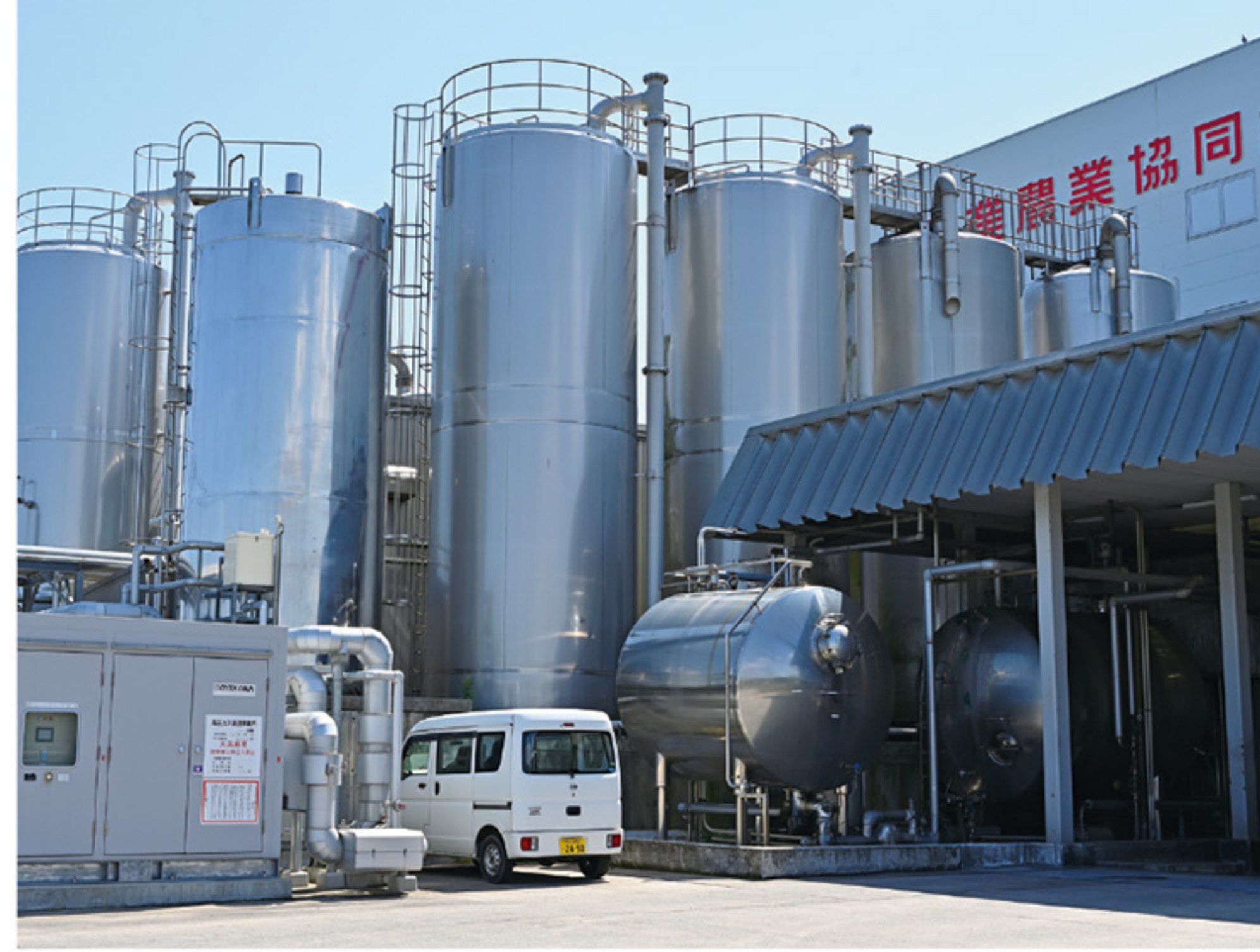
農家から届いた生乳を一時保管する貯乳タンク
