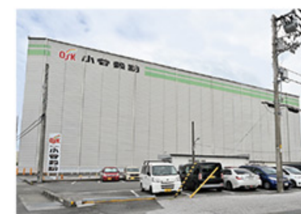
株式会社小谷穀粉 本社工場 建物は巨大なハイテク倉庫
