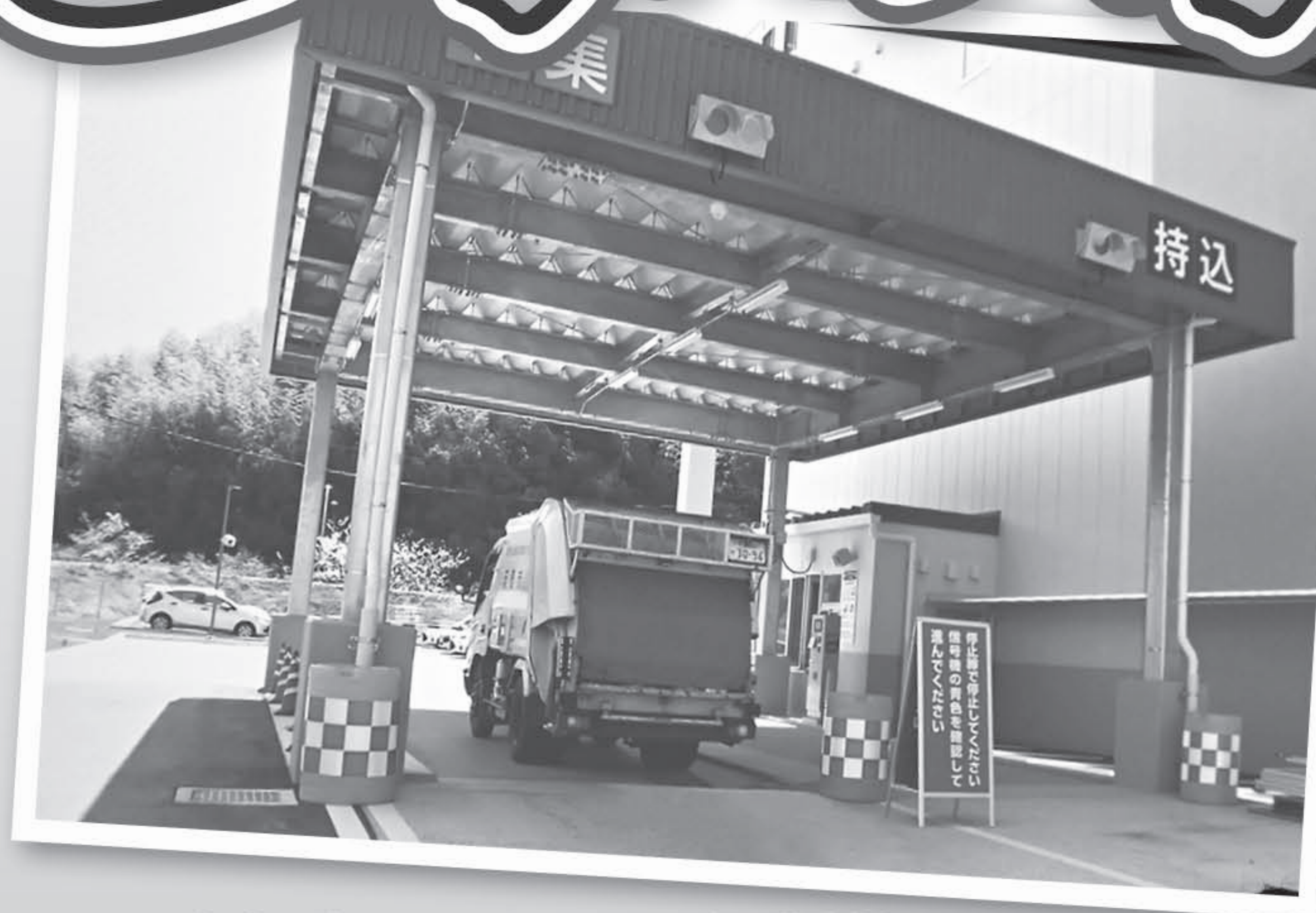
普通の道のように見えるけど、実は計量機になっているよ
